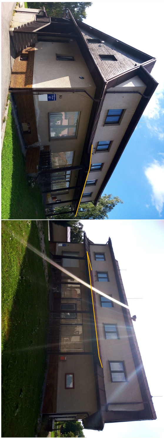
ODSTRANĚNÍ STRÍŠKY U VCHODU, ÚPRAVA DO NAVAZUJÍCÍHO TVARU OBVODOVÉ STRÍŠKY, VČETNĚ ODSTRANĚNÍ 4 SLOUPŮ, ÚPRAVY DŘEVĚNÝCH ČÁSTÍ, KRYTINY, SVODU... PŮDORYSNÁ PLOCHA ÚPRAVY cca 26,75 m2
